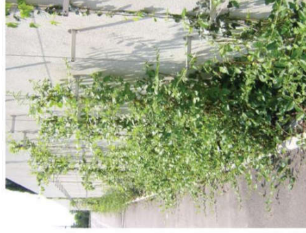
Figure 167. Principe de traitement du mur de soutènement – système de câble et grimpantes (Michel Desvignes Paysage, 2017)
