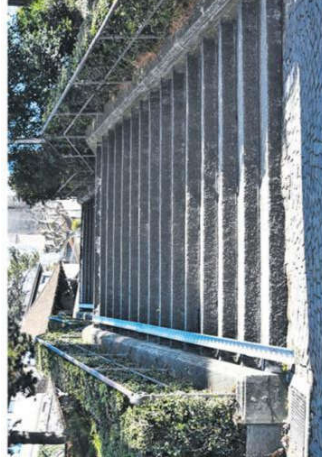
Figure 168. Exemples de traitement de la liaison verticale au niveau de l'ouvrage TCSP – escaliers équipés de rampes à vélo (Michel Desvignes Paysage, 2017)
